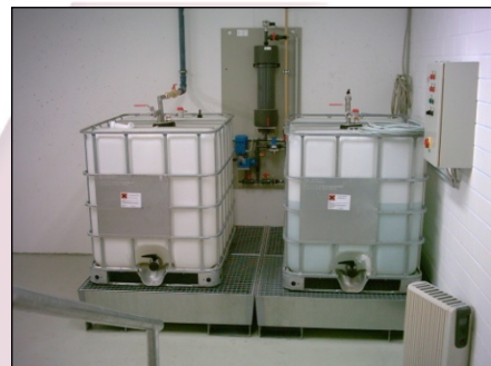
MA-3000 Zentrale Formalin-Ver- und Entsorgungsanlage mit je einem 600 Liter Behälter für Frisch - und Alt-Formalin
