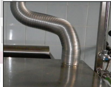
Anschluss an hauseigene Ventilation
