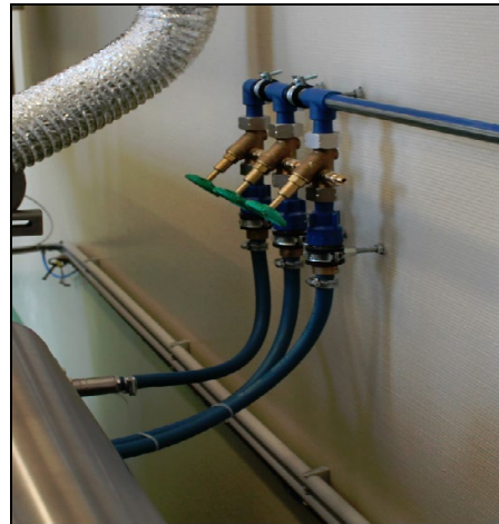
Beispiel des Zulaufs an einer Mazerationsanlage mit 2 Kammern (mittlerer Hahn zur Versorgung der Brause)
