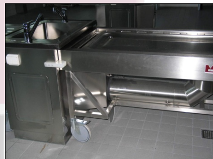
Abluftleitung in der Verbindung mit der Andock-Station
